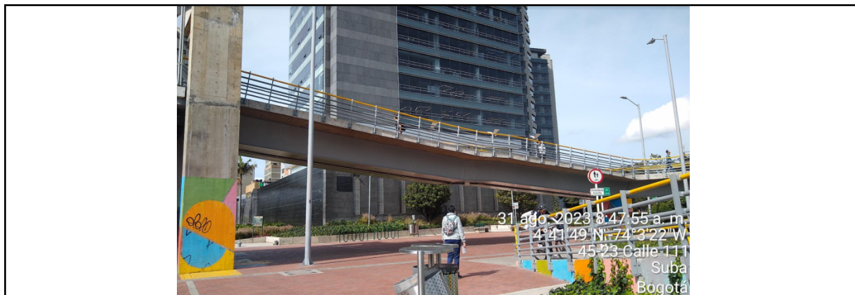
Fotografía No. 1 Puente peatonal
